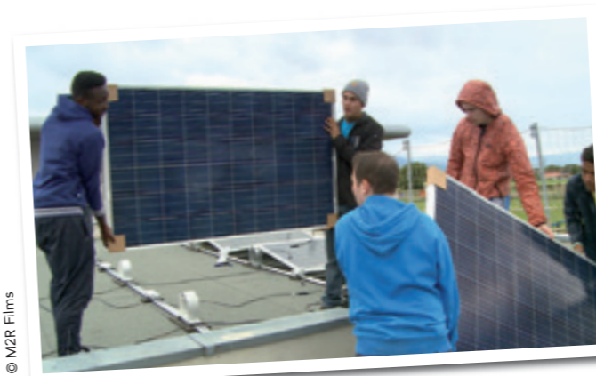
• Installation de panneaux photovoltaïques sur un bâtiment municipal
